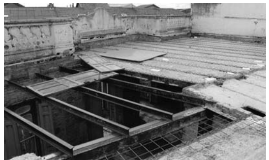
Figura 11 Casa de Norberto Macho (1915). Imagen de las viguetas y de las vigas del forjado de la planta segunda, tomada durante el proceso de restauración (1994). (Archivo particular del arquitecto Julio Bruhalla Santos-Funcia)
