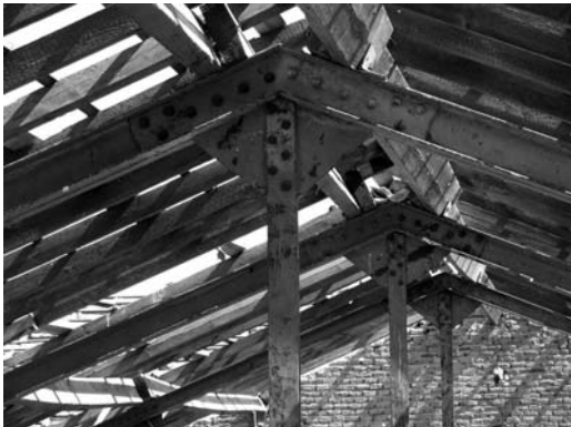
Figura 9 Salón-Teatro Nuevo (1911). Cerchas de hierro de la cubierta, tomadas durante el proceso de derribo para su restauración y rehabilitación (2006). (Archivo particular del arquitecto Ángel Fernández Poyo y del Arquitecto Técnico Francisco Fuentes Vicario). 9
