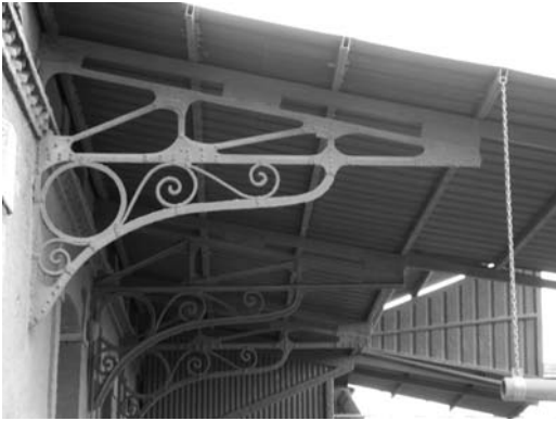
Figura 6 Fábrica de Harinas Gabino Bobo en Zamora (1902). Imagen de las ménsulas que soportan la marquesina posterior que protege el desembarco de productos
